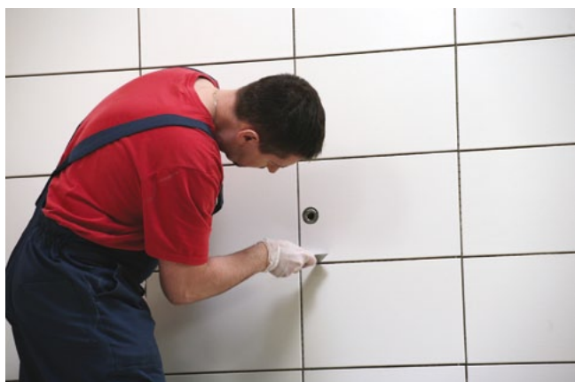
Vyčištění spár a okrajů od zbytků lepidla.
